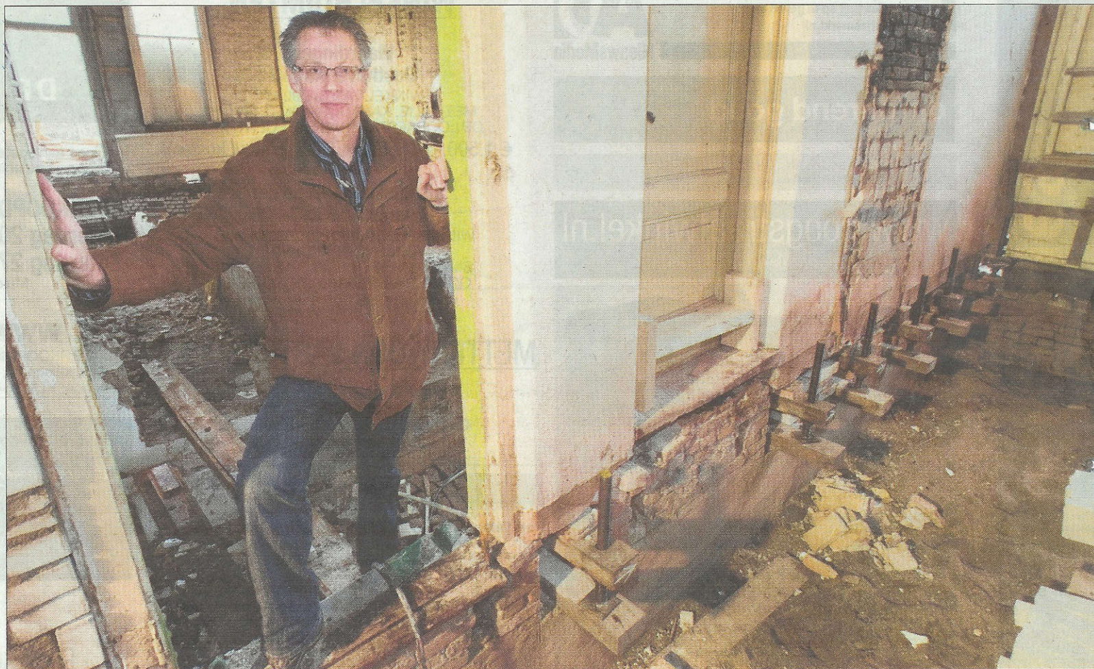
Henk Simonse in zijn boerderij: 'Het was ondoenlijk om de vloer te egaliseren. Om die reden kwamen we op het idee het pand op te vijzelen.'
